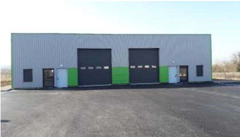
Plan masse de l'atelier relais n°6 de la ZA Le Vigneau à St Paterne Racan
